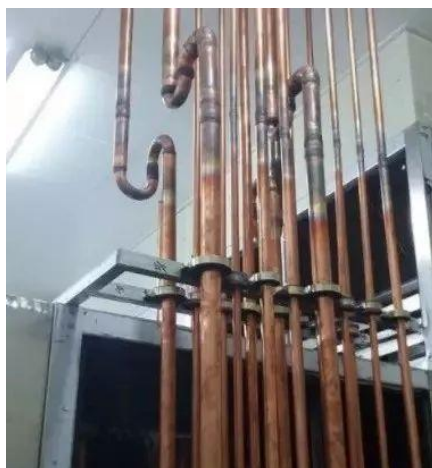
图 1 利用存油弯的自然补偿及固定支架
